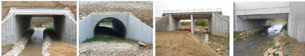
Joonis 3. Truupid, mis on kohandatud ka loomadele läbipääsuks 36
